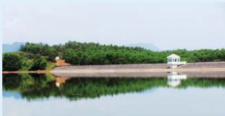
Hồ thủy lợi An Mã (huyện Lệ Thủy) do Công ty quản lý, khai thác
