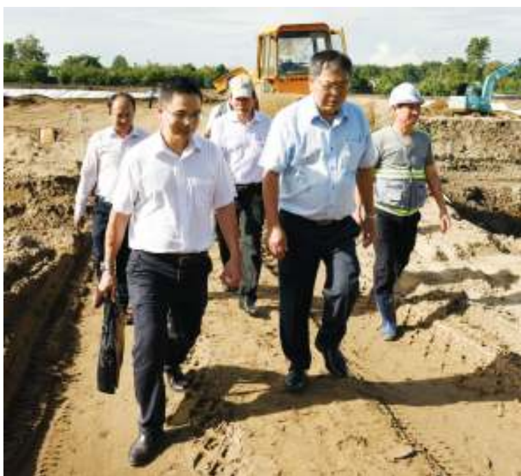
Phó Chủ tịch UBND tỉnh Hậu Giang - ông Nguyễn Văn Tuấn cùng các sở, ngành liên quan khảo sát việc thi công Nhà máy điện mặt trời Hậu Giang vào tháng 7/2020
