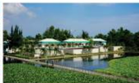
Nhà máy xử lý nước thải tập trung KCN Điện Nam - Điện Ngọc
