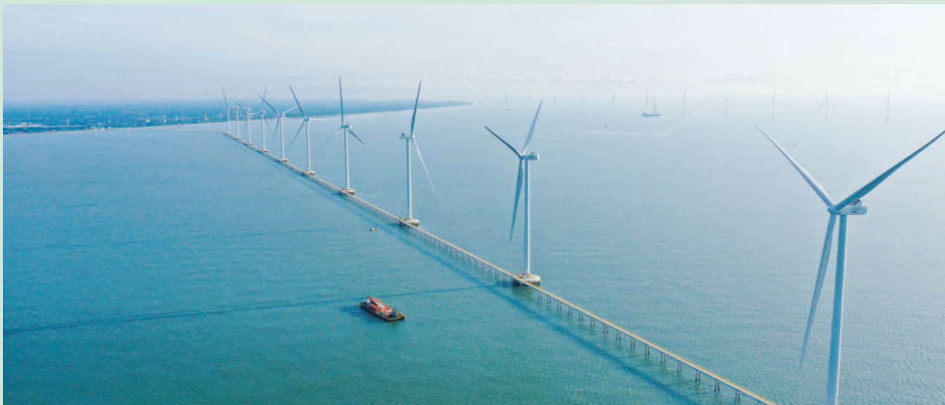
Nhà máy Điện gió Hàn Quốc - Trà Vinh trong KKT Định An
