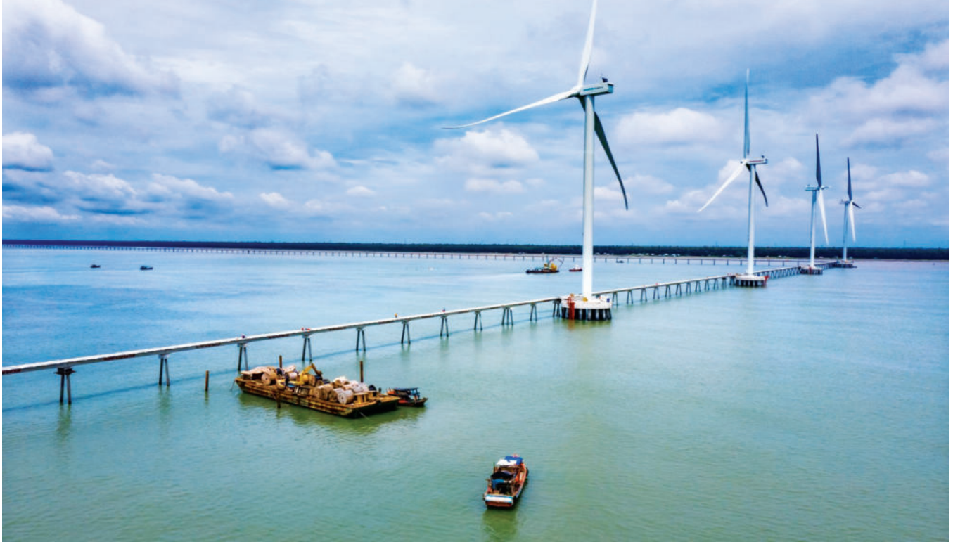
Các dự án điện gió đang tạo thêm nguồn lực phát triển kinh tế cho tỉnh Trà Vinh
