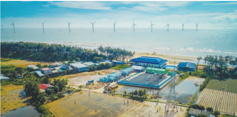
Toàn cảnh Nhà máy điện gió V1-2 (Điện gió Trường Thành Trà Vinh) tại ấp Cồn Trứng, xã Trường Long Hòa, thị xã Duyên Hải
