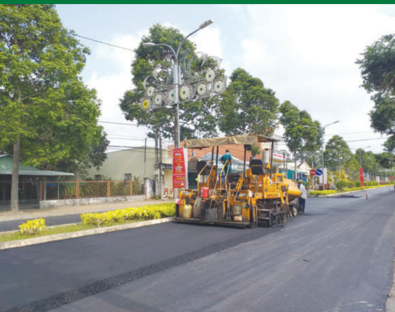
Công ty Sông Hậu thi công trải thảm bê tông nóng tại đường Trần Hưng Đạo, TP.Sóc Trăng
