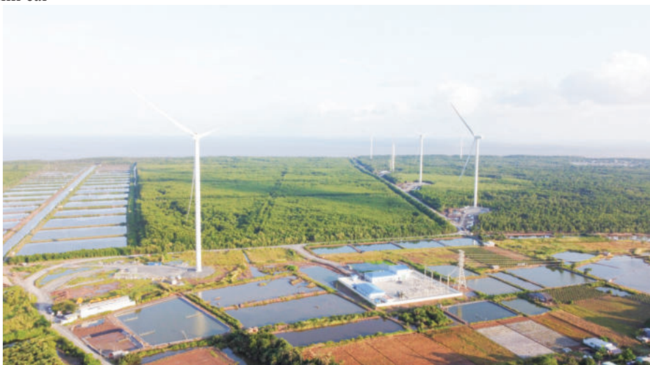
Nhờ đẩy nhanh công tác bồi thường, GPMB (do VPĐKĐĐ tỉnh Sóc Trăng thực hiện), dự án Nhà máy điện gió Quốc Vinh Sóc Trăng (nhà máy điện gió số 6 tại thị xã Vĩnh Châu) đảm bảo tiến độ triển khai và đi vào vận hành
