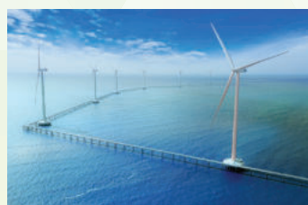
Một dự án điện gió tại xã Vĩnh Hải
