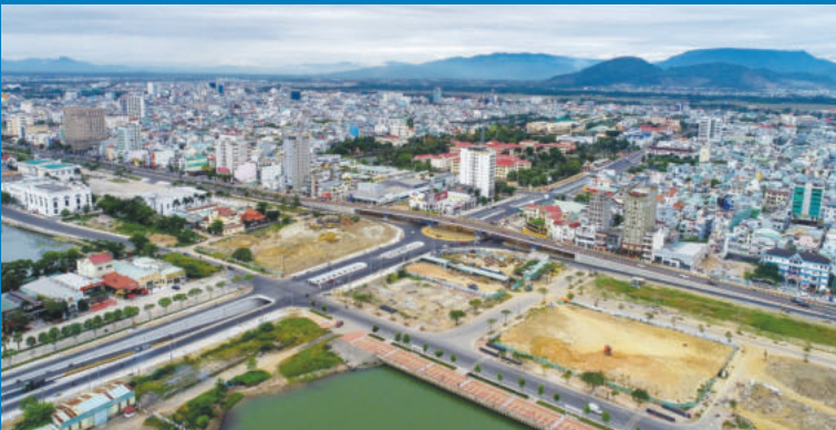
Dự án cải tạo nút giao phía Tây cầu Trần Thị Lý
