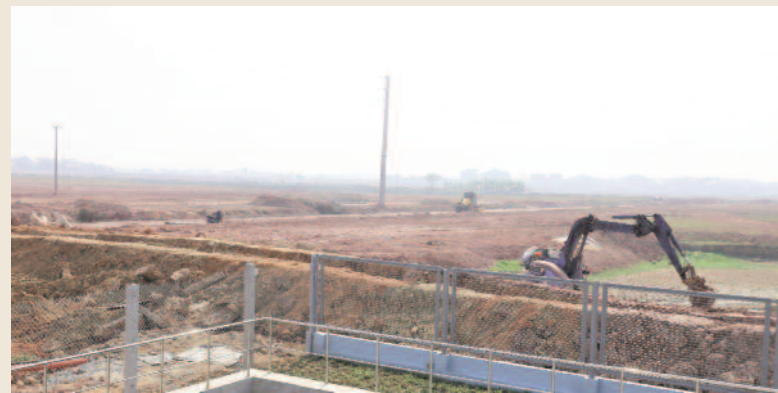
Thi công hạ tầng tại CCN Thanh Vân, huyện Hiệp Hòa
