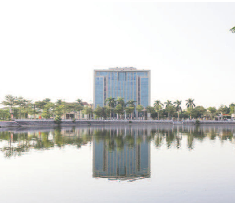
Trụ sở làm việc của huyện Việt Yên do Ban làm chủ đầu tư mới được hoàn thành, được đánh giá cao về các yêu cầu kiến trúc, kỹ thuật, mỹ thuật, công năng sử dụng
