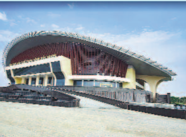
Công trình nhà thi đấu tỉnh Bắc Giang
