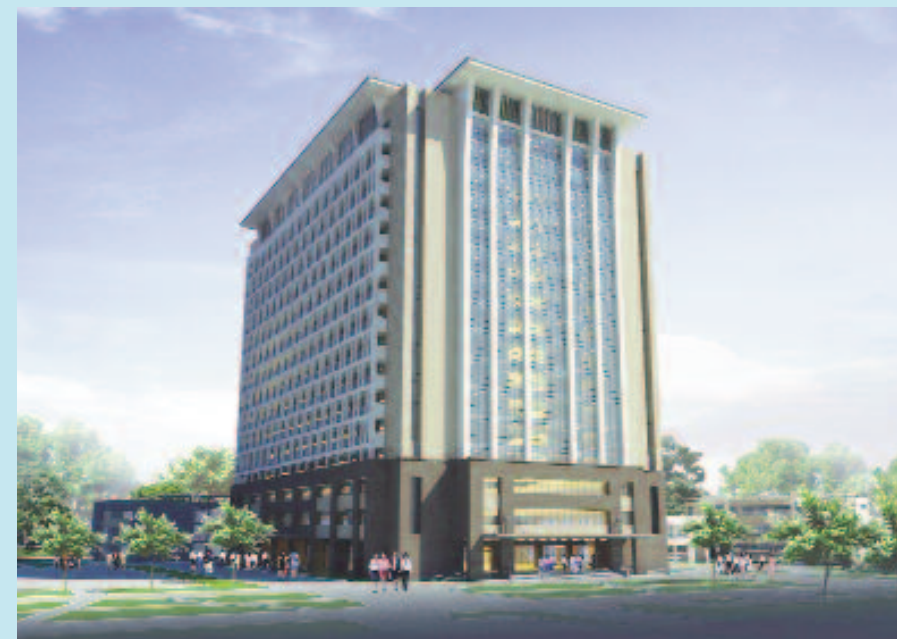
Dự án Khối nhà trung tâm, khối nhà chuyên khoa đặc thù, khoa truyền nhiễm và các hạng mục phụ trợ của BV Đa khoa tỉnh Bắc Giang
