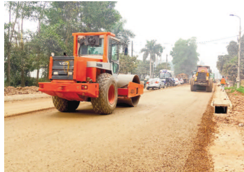
Tuyến QL 17 đoạn thị trấn Nhã Nam - thị trấn Phồn Xương (Yên Thế) đang được đầu tư cải tạo, nâng cấp
