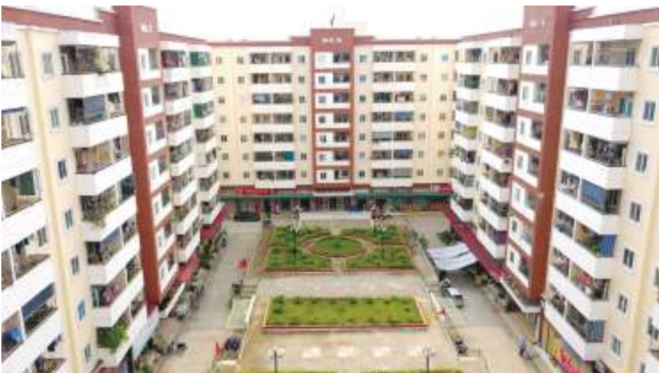
Dự án Khu nhà ở xã hội phường Quang Trung, thành phố Thái Bình do TBDIF làm chủ đầu tư
