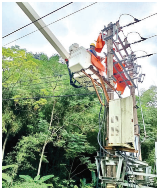
Sửa chữa lưới điện bằng công nghệ hotline
