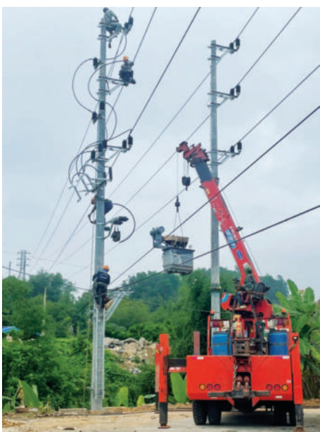
Lắp dựng TBA chống quá tải lưới điện
