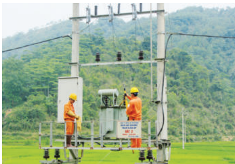
Kiểm tra, bảo dưỡng lưới điện
