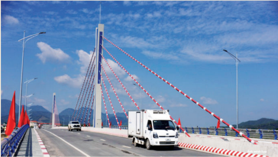
Cầu Hòa Bình 2 góp phần quan trọng trong phát triển kinh tế - xã hội của thành phố Hòa Bình, tỉnh Hòa Bình
