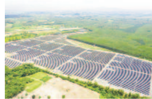
Năm 2020, sản xuất công nghiệp Bình Phước tăng 12,5%, đóng góp lớn cho NSNN của tỉnh, trong đó có sự góp phần của Dự án Nhà máy điện mặt trời Lộc Ninh do Tập đoàn Hưng Hải đầu tư
