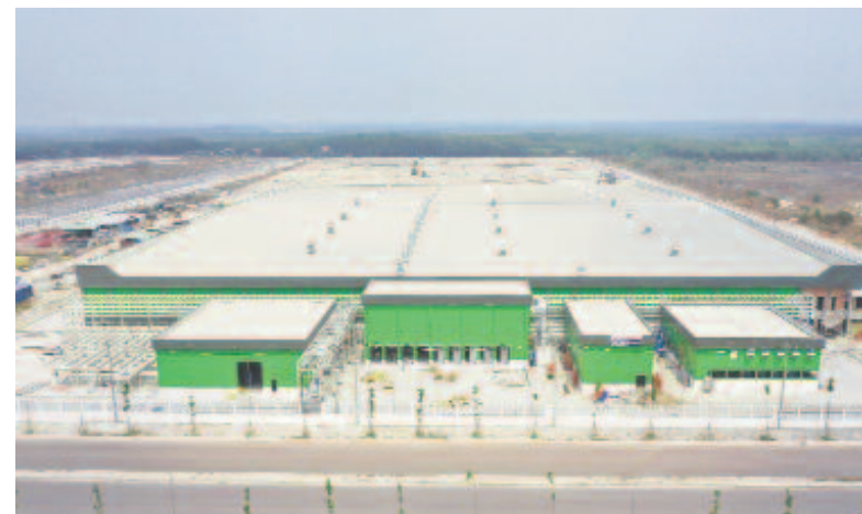
Công ty Hayat Kimya
