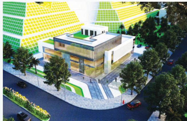
CCN Phú Thịnh 3 dự kiến đưa vào hoạt động từ Quý IV năm 2026
