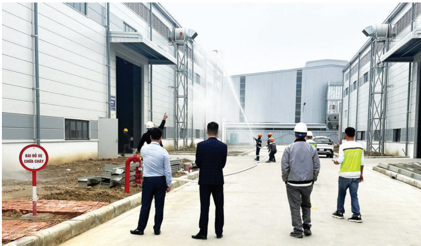
Đoàn công tác PC07 - Công an TP.Hải Phòng kiểm tra và thử nghiệm các thiết bị PCCC do Công ty cung cấp, thiết kế, lắp đặt đều đảm bảo và được đánh giá cao
