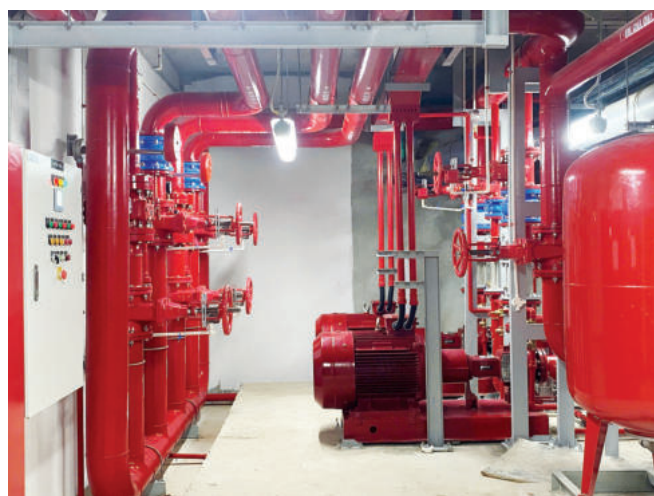
Một trong những hạng mục lắp đặt hệ thống thiết bị PCCC tại dự án “Khu du lịch, dịch vụ thương mại Vịnh trung tâm Cát Bà”
