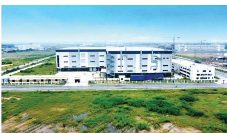
Một số nhà đầu tư thứ cấp đã hoàn thiện xong nhà xưởng và đi vào sản xuất
