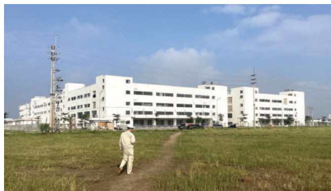
Dự án 10 nhà kho liên kế kho vận Semcorp trong KCN VSIP Nghệ An
