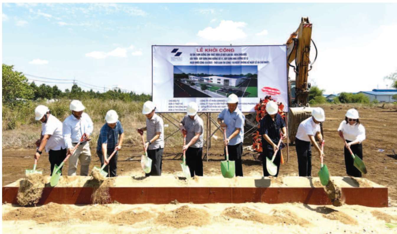
Lễ khởi công cụm nhà xưởng giai đoạn 2 tại KCN Châu Đức
