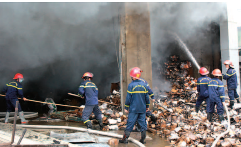
Lực lượng Cảnh sát PCCC&CNCH - Công an tỉnh Bắc Ninh triển khai chữa cháy tại xưởng chứa gỗ ép H.N, thuộc tổ dân phố Song Khê 1, phường Tiên Phong, ngày 21/8/2025. (Ảnh: Báo Bắc Ninh)
