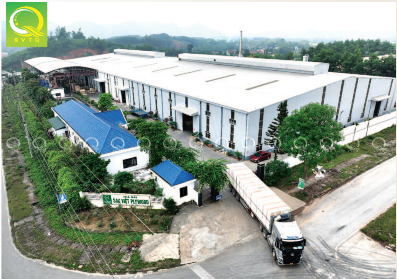
Nhà máy sản xuất gỗ ván ép PLYWOOD của Công ty Sao Việt Tuyên Quang tại Khu công nghiệp Long Bình An
